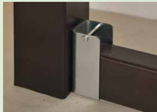
Detail úchytky s fixačním šroubem
